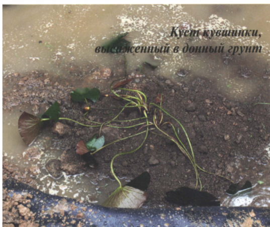
Размещение посадочного грунта для водных растений поверх гидроизоляции
