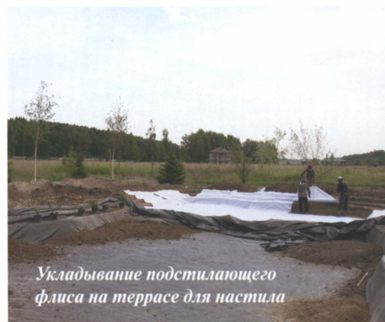
Раскатывание гибкого гидроизолирующего покрытия
